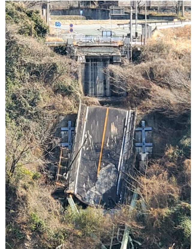
熊本地震で落ちた旧阿蘇大橋 (熊本県南阿蘇村、2026年2月 入江撮影)
